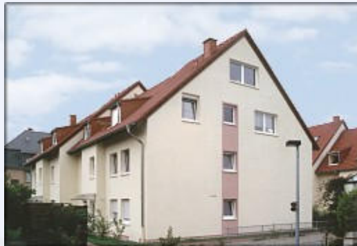
Mehrfamilienhaus in Oberlahnstein
